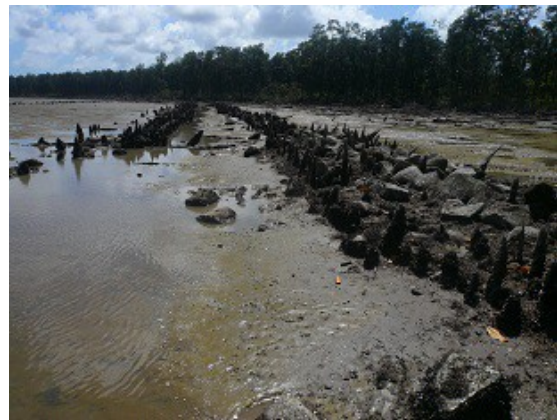
Détail des anciens pieux et de l'enrochement à marée basse en 2010
