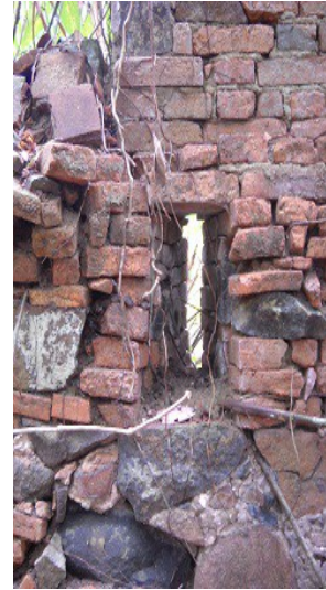
Meurtrière de l'habitation du quartier Général
