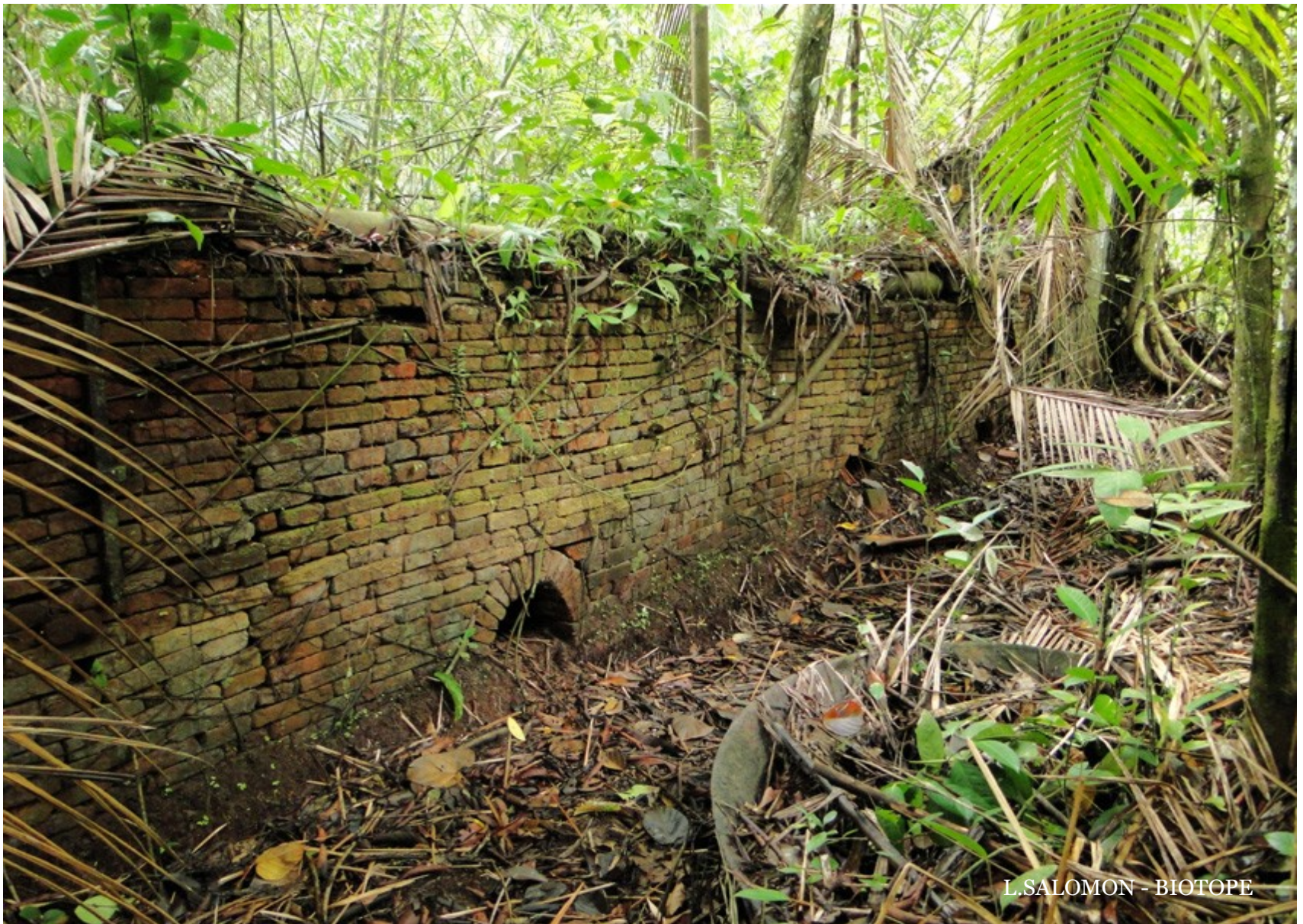
La Marie Tunnel de chauffe de l'équipage de chaudières
