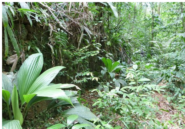
Mur de soutènement de la terrasse
