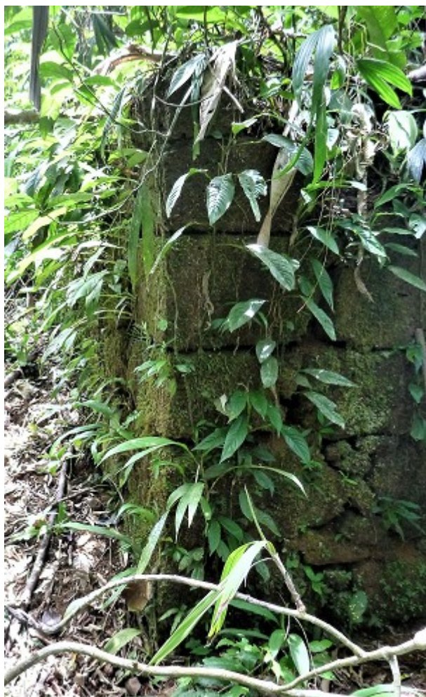
Détail d'un angle du mur de soutènement de la terrasse
