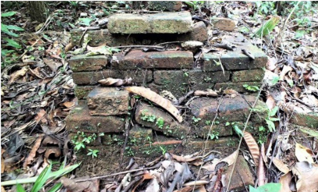
Détail d'un plot maçonné en briques et pierres
