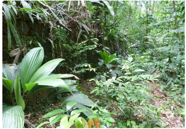
Mur de soutènement de la terrasse
