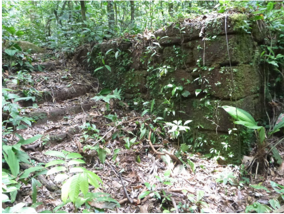
Escalier de sept marches ouvert dans le mur de soutènement
