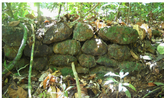
Mur de la terrasse inférieure du troisième bâtiment.
