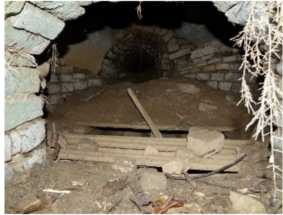
Illustration 2: Vue intérieure du four avec le départ du conduit de chauffe et les barres métalliques du cendrier
