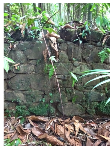
Soubassement du chemin
