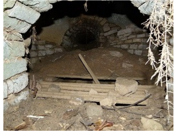
Illustration 2: Vue intérieure du four avec le départ du conduit de chauffe et les barres métalliques du cendrier
