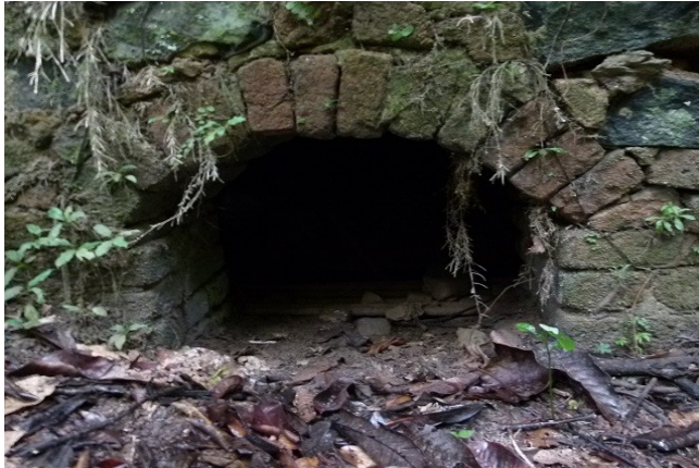
Illustration 1: Vue extérieure d'un des deux fours
