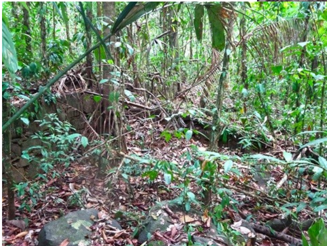
Escalier sur le devant et soubassement de la maison
